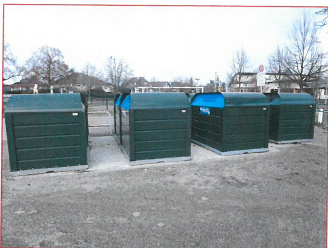
Réalisation d'une dalle en béton pour accueillir les conteneurs de tri sélectif
