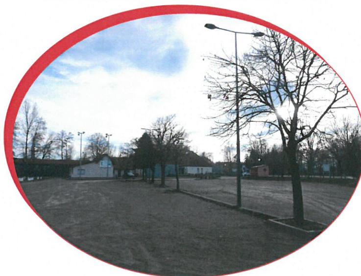
Nouvel éclairage basse consommation et remise à niveau du parking
