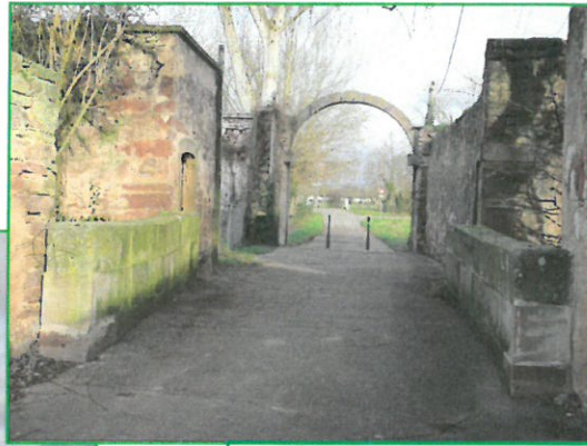
Porte de sortie Nord
