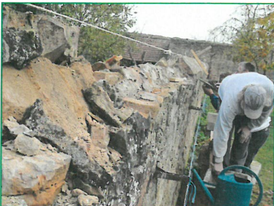
Mur de l'enceinte à rénover
