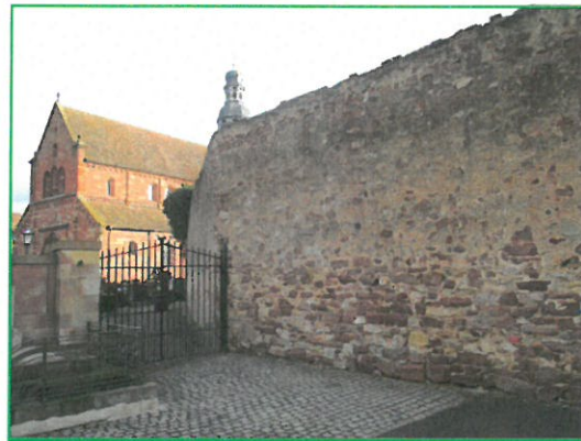
Le mur de la clôture
