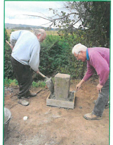
Pose de la dernière borne du sentier trouvée au fond du fossé
