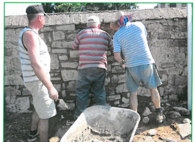
Restauration des murs du jardin
