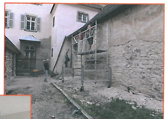
Travaux réalisés par l'équipe municipale
