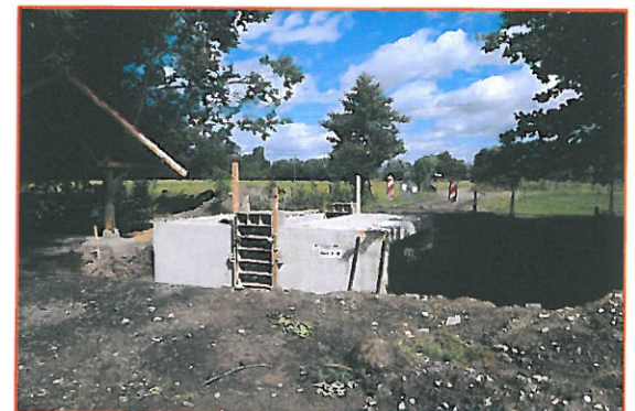
Renforcement du pont au niveau du lavoir
