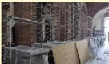
Protection de l'orgue et la tribune (cloison avec bâche sur ossature en bois, encoffrement en OSB posé sur la partie
