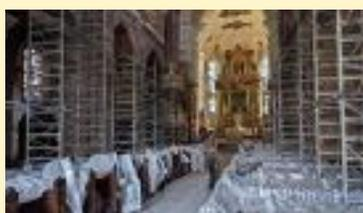
Terminer la mise en place des platelages en OSB dans l'allée centrale, le narthex et à l'entrée de la croisée du transept, par-dessus les bâches fibrées déjà en place.
