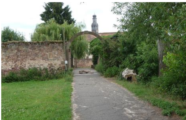
Mur d'enceinte au nord de l'abbaye
