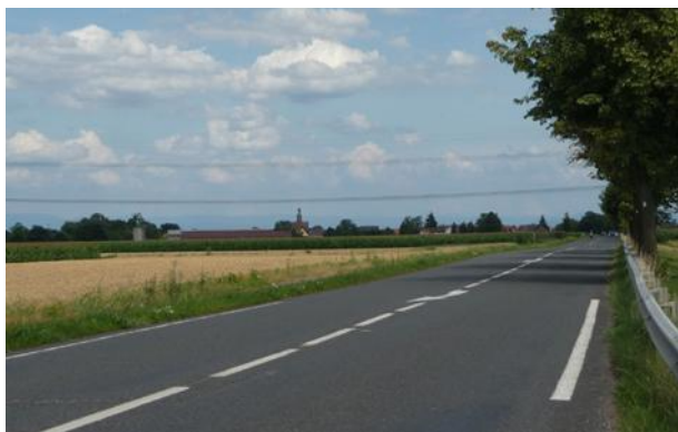
Route de Strasbourg (RD 392) depuis Dorlisheim
