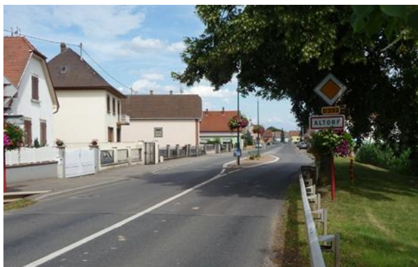
Route de Strasbourg (RD 392) depuis Dorlisheim
