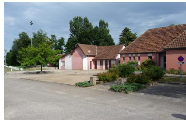
Maison du temps libre - rue de Dachstein
