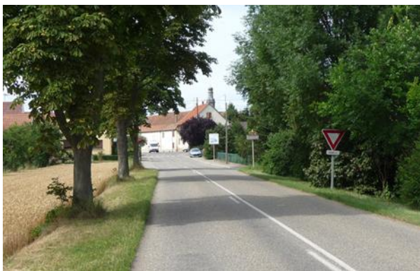
Route de Griesheim (RD 127) depuis Griesheim
