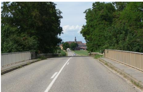
Route de Griesheim (RD 127) depuis Griesheim
