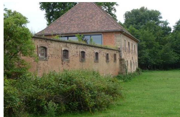
Transformation en logement de l'ancien Moulin
