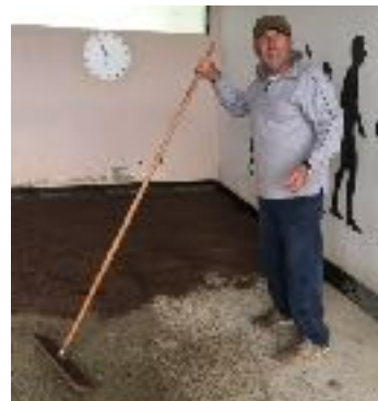
Photo 6 : Rénovation Du Hall (Gilles Michaud)
